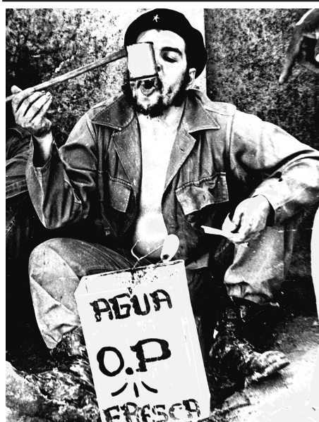
O Comandante guerrilheiro argentino-cubano na construção de casas para moradores de Las Yaguas, em 1961.
