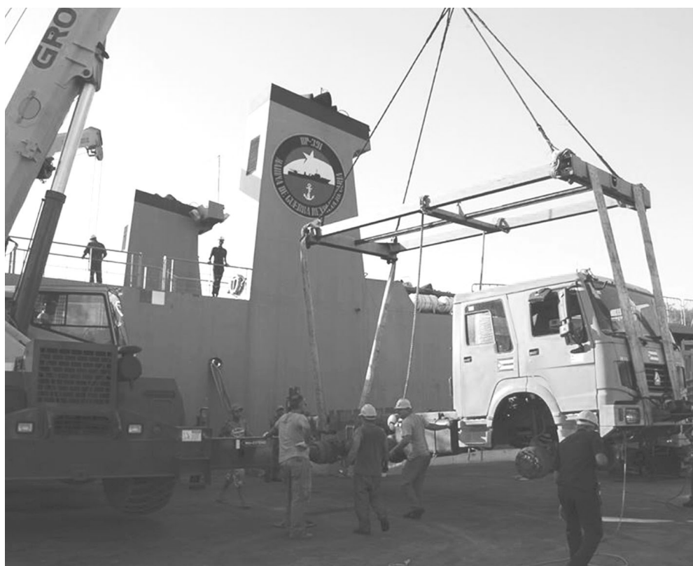
O primeiro obstáculo que os especialistas elétricos cubanos tiveram que superar foi desarmar os caminhões para que pudessem ser descarregados no porto de Roseau.
