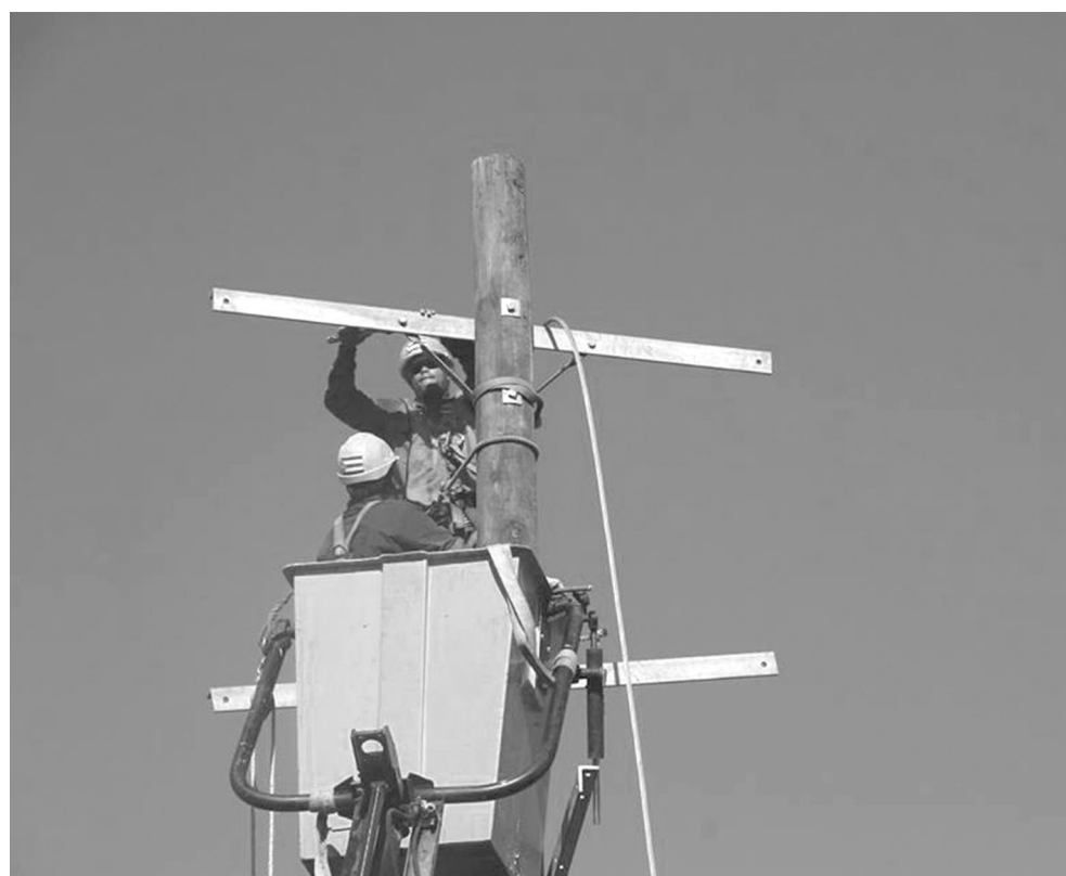
Os reparadores instaladores cubanos trabalham em uma linha de transmissão primária que ligará a capital com a usina hidrelétrica de Trafalgar, a oito quilômetros de distância.
